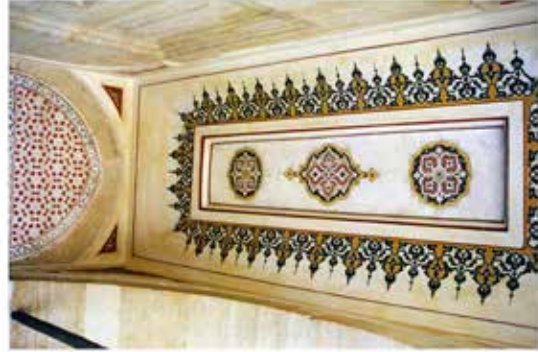
1983 onarım sonrası yan açık mahfil tavanları.
